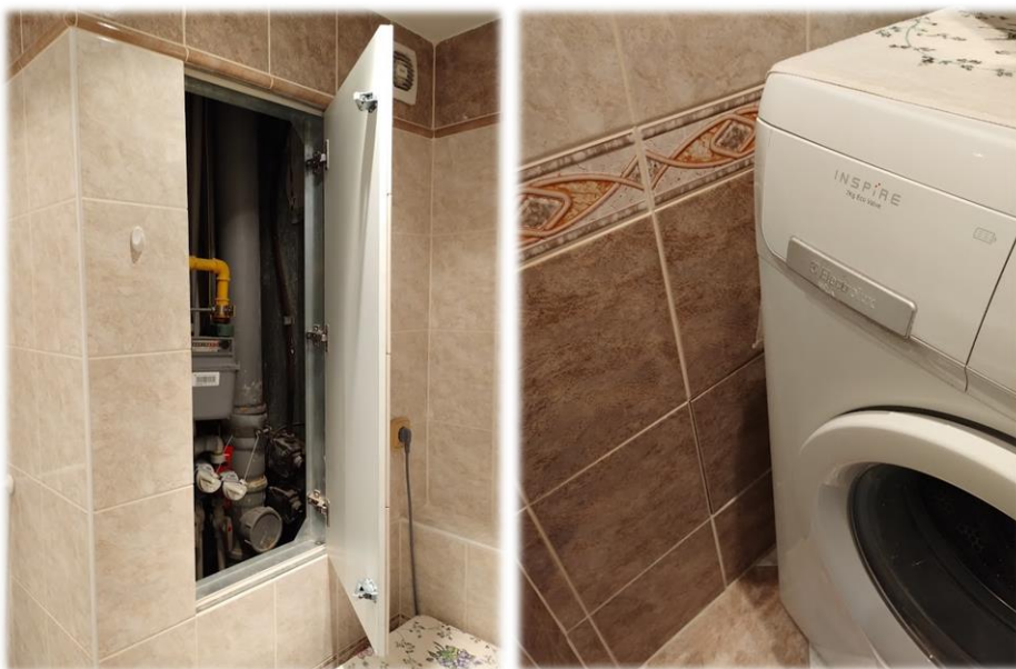
Vlevo – dvířka 100 x 40 cm, vpravo – dvířka nad podlahou (vedle pračky) – vyndavací na magnet 25 x 40 cm (rozměr na dvě dlaždičky)
